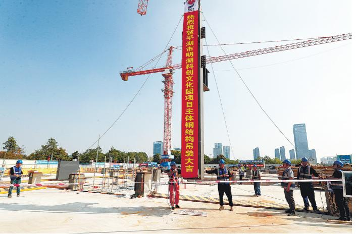
“3、2、1,起吊!”只见塔吊大臂开始舞动,钢柱缓缓升起、旋转,一根重达8吨的钢柱精准下落稳就位……近日,平湖市明湖科创文化园项目主体钢结构吊装大幕开启。构造型新颖独特、异形构件多、跨度长达38米,现场安装、定位、焊接,都是一次不小的挑战。为了进一步提高施工精度和效率,项目还引入了机器人焊接技术。
