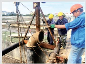
近日,绍兴市上虞区水处理公司工业线二沉池排泥及进水管改造项目现场,设备检修人员在大型挖机配合下,有条不紊地开展着不锈钢管道铺设埋地工作。该项目计划于今年12月上旬之前完成改造。
