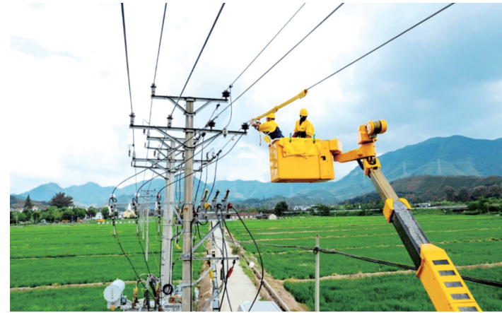
国网杭州市余杭区供电公司员工带电开展10千伏线路开关两侧引线作业。
